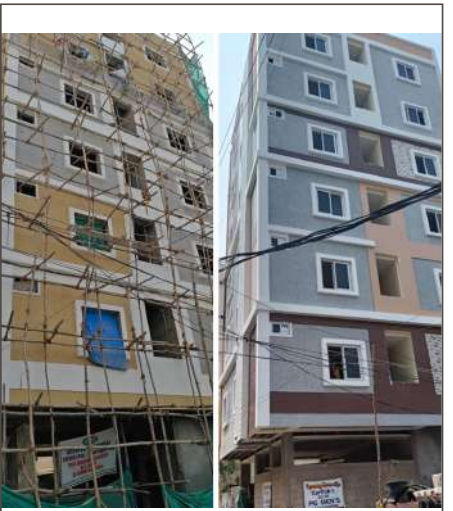
సీజ్ చేసిన భవనం నిర్మాణం పూర్తి (నాడు - నేడు)
