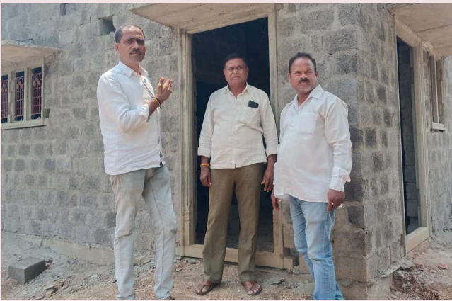
మోడల్ ఇందిరమ్మ ఇంటి నిర్మాణం పరిశీలన
